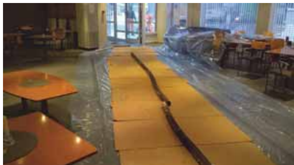
Pumping av sement til kjellergulv
